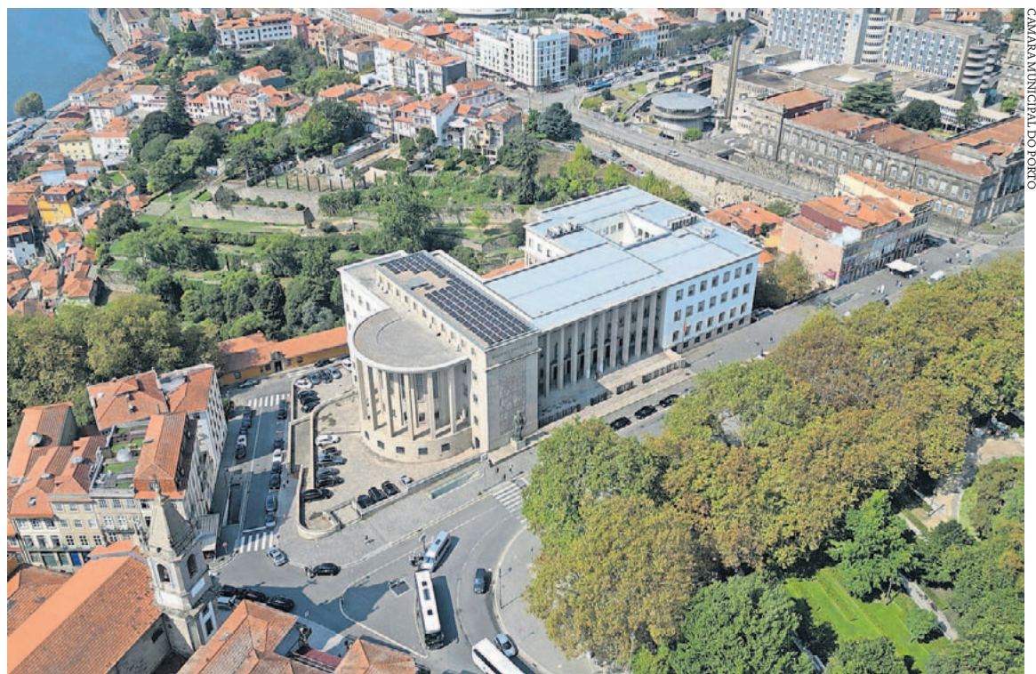
Os 83 painéis solares estão a funcionar, no telhado do edifício, desde finais de julho passado
